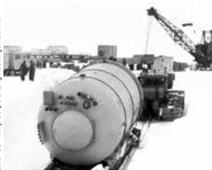
Transport der Reaktorkomponenten zum „Camp Century“ durch Schlitten
