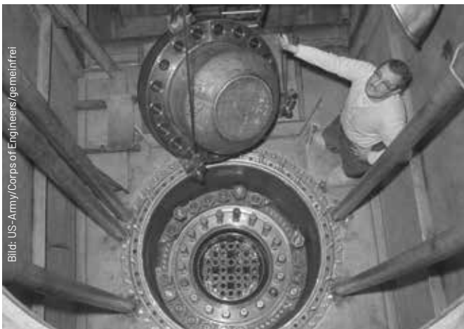
Blick in den modular errichteten Reaktor. 10 MW thermische Leistung wurden durch nur 20 kg Uran mit 93 % Anreicherung an U-235 erreicht
