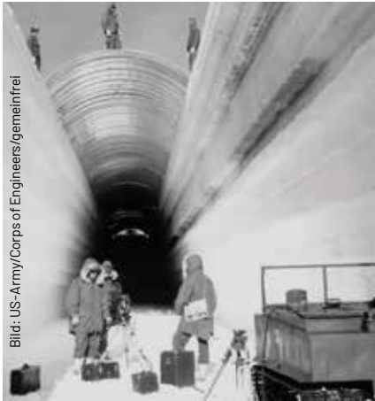
Bild: US-Army/Corps of Engineers/gemeinfrei In Eis gefräste und überdachte Gänge verbanden die unterirdischen Einheiten des „Camps Century“ miteinander
